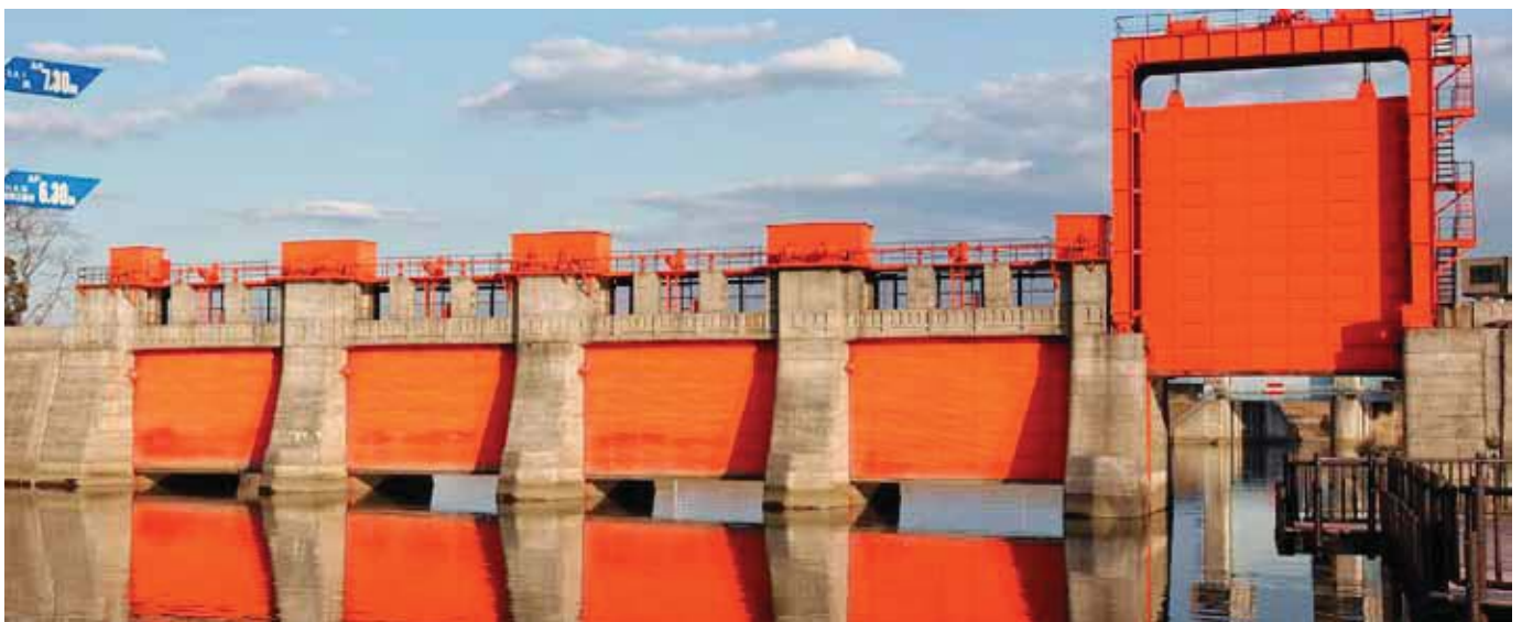
東京の歴史上重要な「岩淵」水門。日本の河川は流れが急で洪水を起こしやすく、この水門は2つの河川に沿って生活しているコミュニティにとって重要な役割を果たしている。© Juergen Sack
