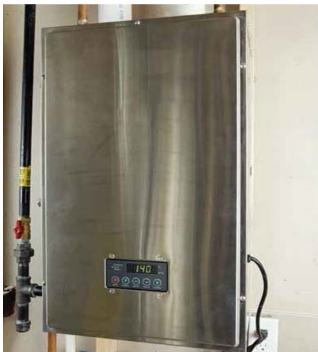
異種のを組み合わせて凝縮させたタンクのない住居用の湯沸器。この技術は、需要に応じて湯を沸かすもので、従来の湯を溜めるタンク式よりもエネルギー効率はるかに良い。© BanksPhotos/iStock
